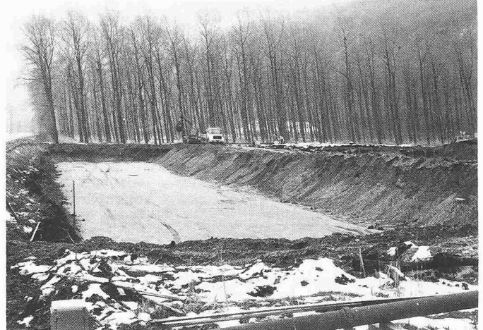
Bild 3. Das Becken für die gesicherte Deponie ist teilweise ausgehoben
