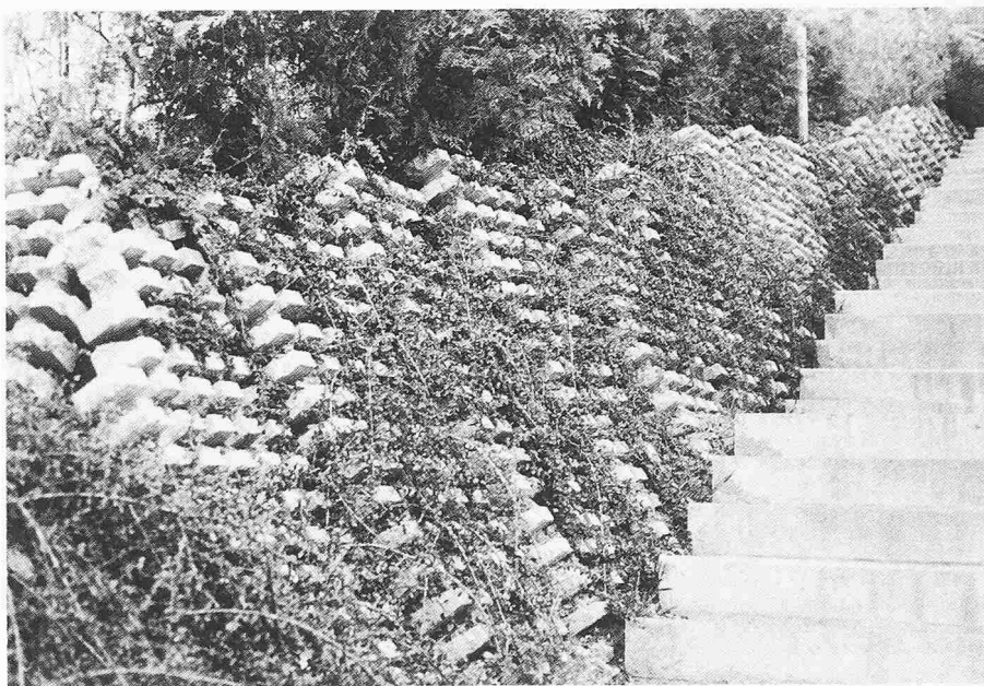
Bild 1. Rasengittersteine ein Jahr nach dem Bestecken mit Cotoneaster, wird später völlig überwachsen
