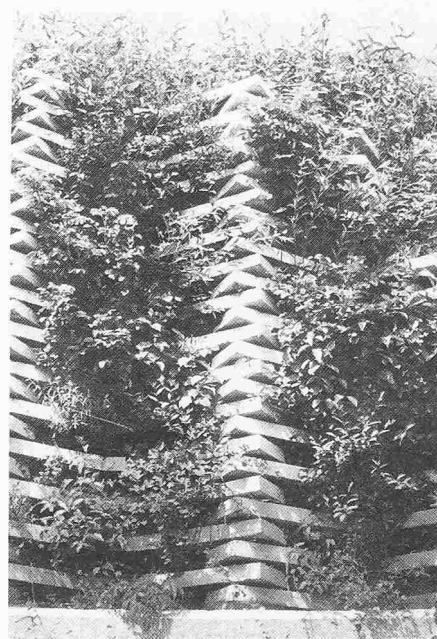
Bild 4. Sternelementmauer mit Heckenbuschlagen fünf Monate alt
