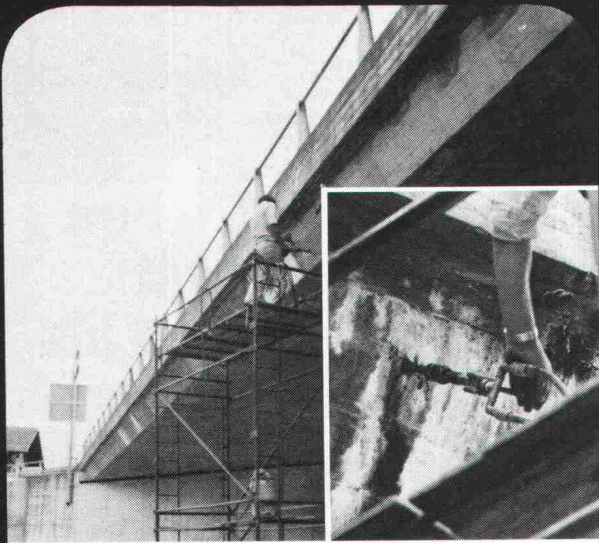
Risse in Betonbauwerken Abdichtung mit Renesco- Flexin-Injektionen
