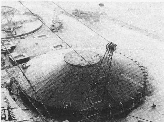
Bild 21. Tonerde-Silo (30 000 t) während des Baues
