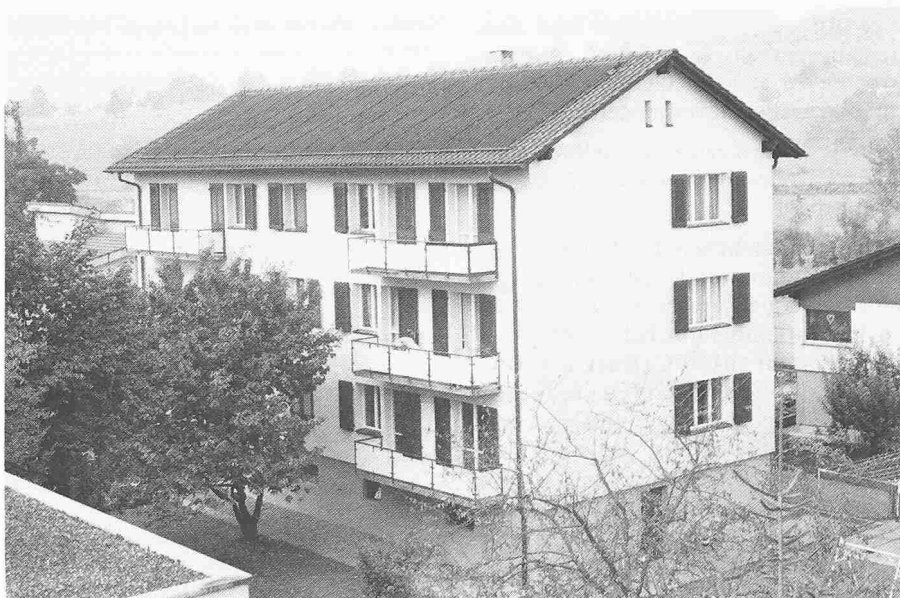
Die Projektliegenschaft in Baar (Kt. Zug)
