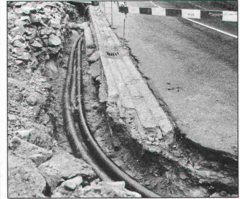
11.55 Komplett verlegt – 360 m nahtlose Fernwärmeleitung – Ziel erreicht!
