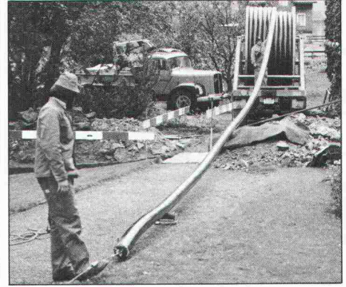
10.04 Die Verlegung der FLEXWELL-Leitung beginnt...
