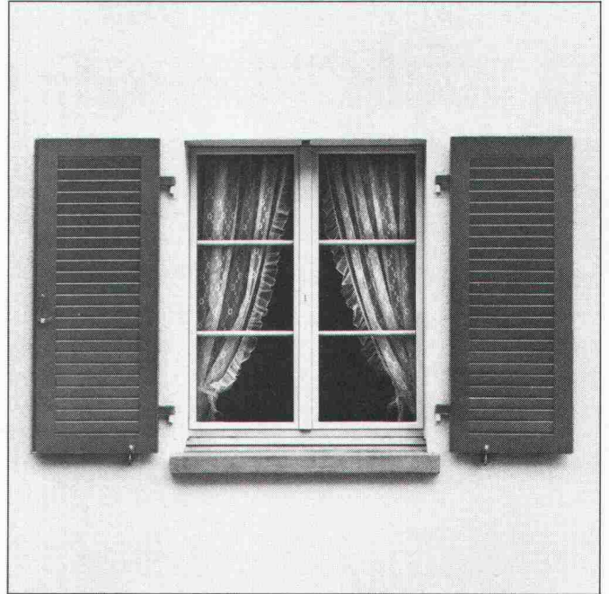
Haus mit aussenisolierter Fassade. Man sieht es nicht.
