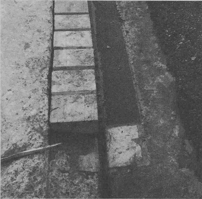
Fugenausbildung zwischen Beton und Asphalt im Wasserbau: Verkleben einer Kupferriffelfolie mit dem Betonuntergrund und vorfabriziertem Abdeckstein mit Haypanol-Metallkleber
