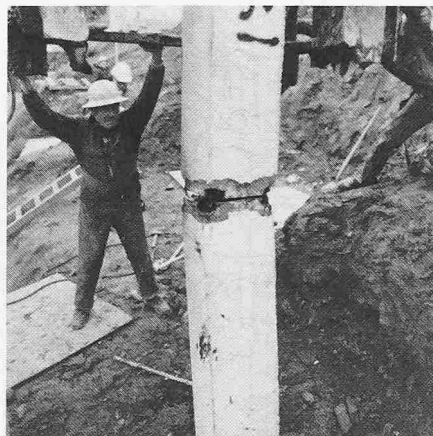
Bild 7. Aufsetzen des oberen Pfahlschusses
