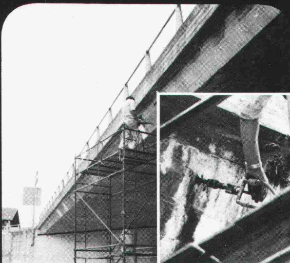
Risse in Betonbauwerken Abdichtung mit Renesco-Flexin-Injektionen
