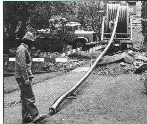
10.04 Die Verlegung der FLEXWELL-Leitung beginnt...
