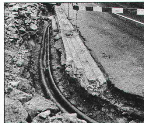
11.55 Komplett verlegt – 360 m nahtlose Fernwärmeleitung – Ziel erreicht!
