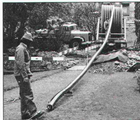
10.04 Die Verlegung der FLEXWELL-Leitung beginnt...
