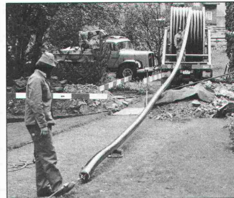
10.04 Die Verlegung der FLEXWELL-Leitung beginnt...
