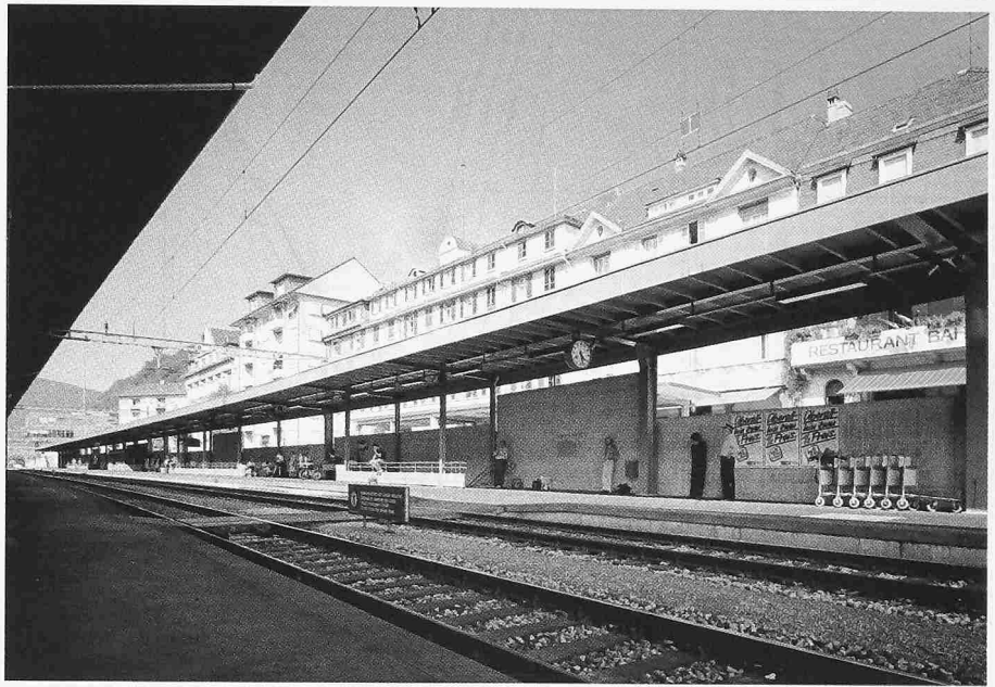
Bild 2. Der neue Aussenperron, links das neue Zentralstellwerk
