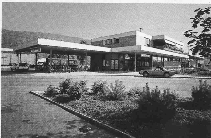
Bild 3. Rothrist: neues Aufnahmegebäude, mit konventionellen Bauteilen
