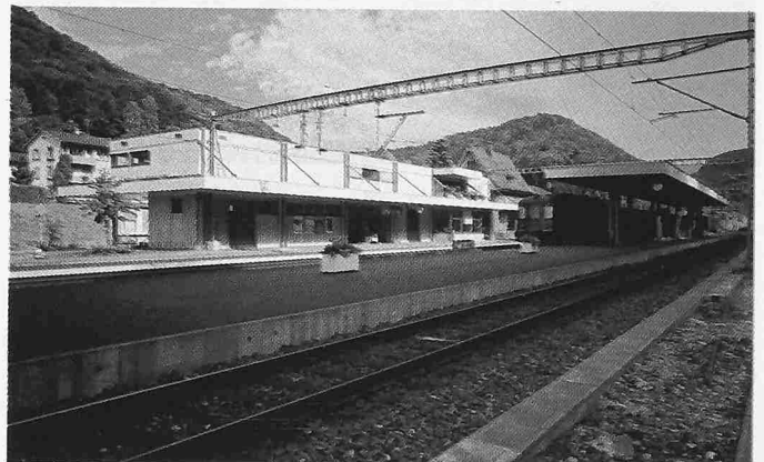
Bild 2. Tecknau: neues Aufnahmegebäude mit teilweise überdecktem Zwischenperron
