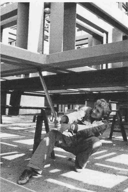
Zusammenbau der einzelnen Träger von Transportgröße auf Grösse der benötigten statischen Felder
