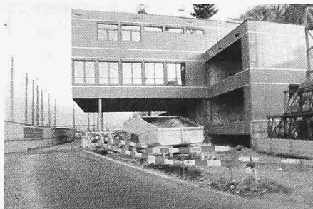
Montage der Fassadenelemente
