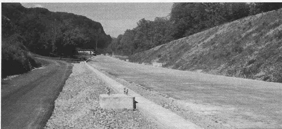
Bild 7. Trasse der neuen Linie, OK Fundationssschicht
