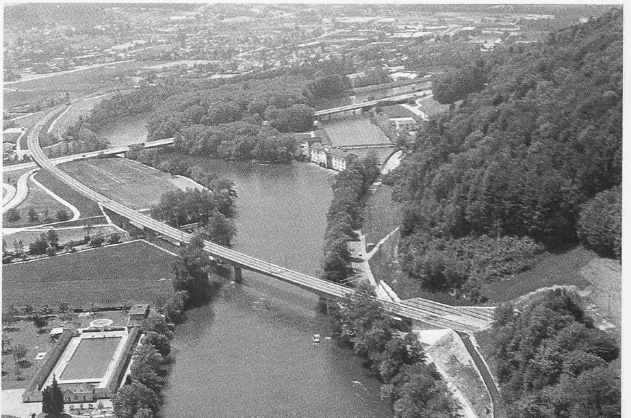
Bild 4. Blick über die Ruppoldingerbrücke vom Borntunnel (Südportal) in Richtung Rothrist
