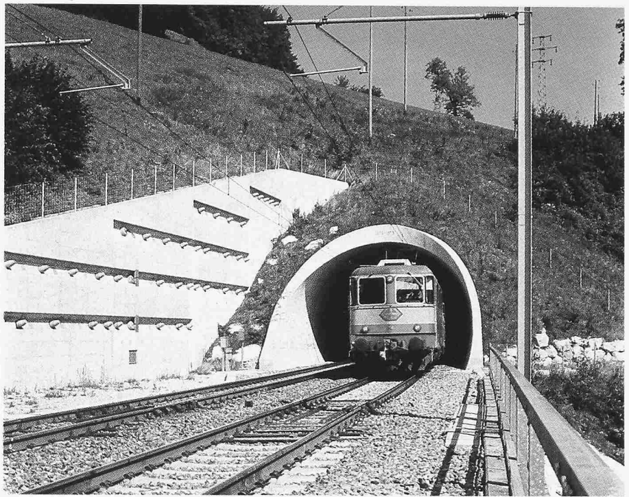
Bild 5. Südportal mit Bohrfahlwand
