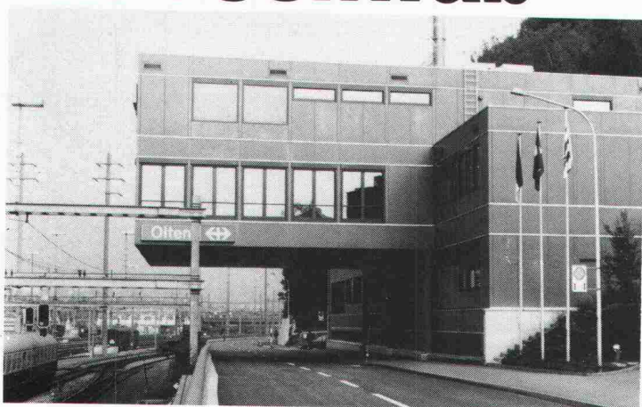
Neues Stellwerk Bahnhof SBB, Olten, Fahrbahnisoliation
