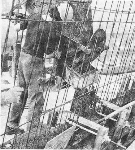
Bild 13. Einbringen von Beton
