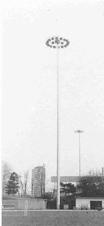
Beispiel eines Schleuderbetonmastes: Beleuchtungsmast (Länge: bis 45 m)
