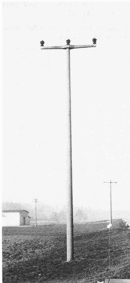
20-kV-Einfachleitung (Tragmast, L = 10-12 m)
