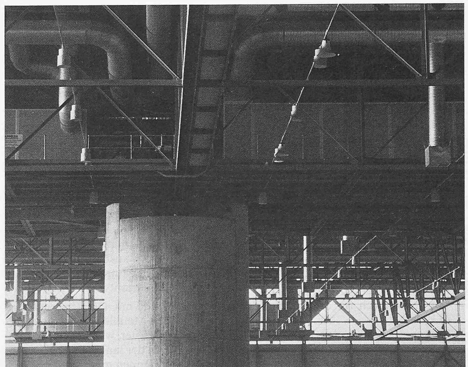
Fertige Stahlkonstruktion im Bereich eines Auflagerturms
