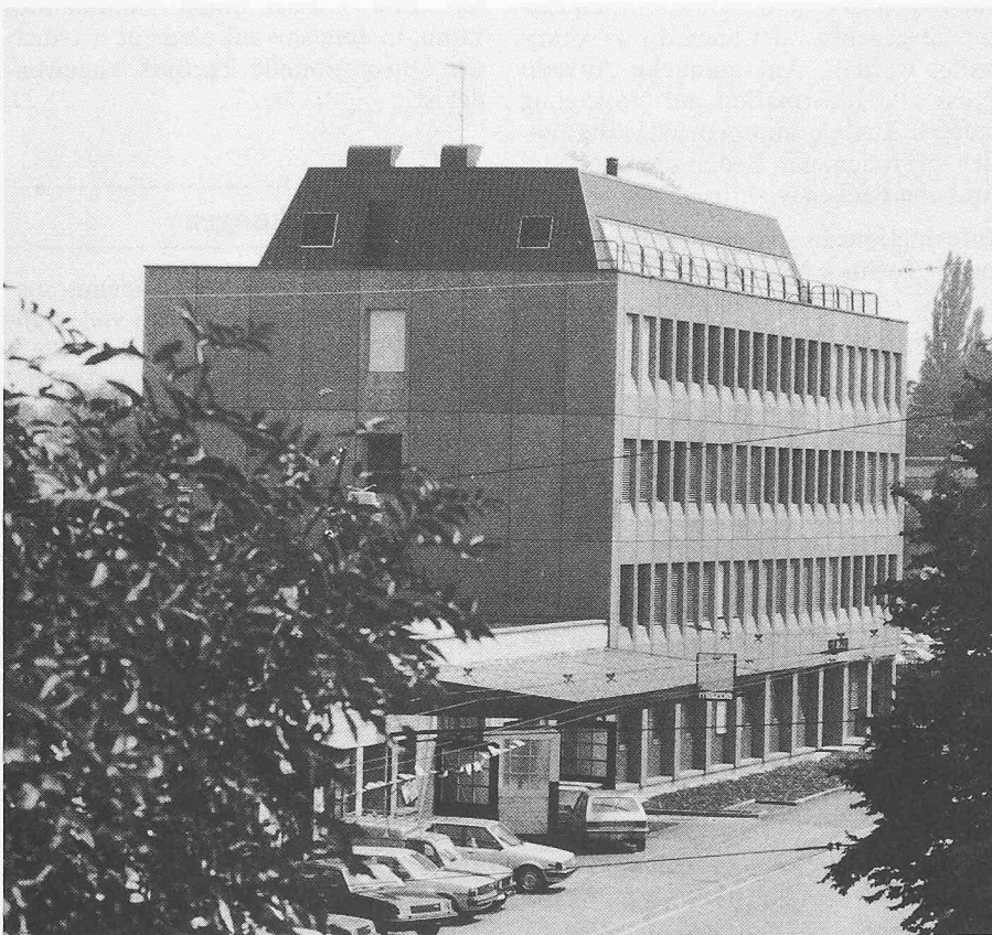
Bild 1. Aussenansicht des Bürotraktes. Sonnenkollektoren in Dach integriert
