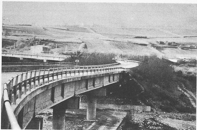
Bild 25. Brücke über den Ofanto-Fluss in der Nähe von Calitri. In der Regel werden die Brücken mit vorfabrizierten, einfachen Balken ausgeführt
