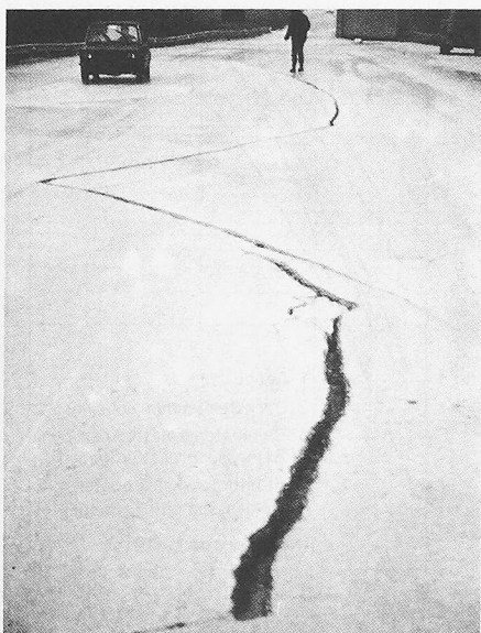
Bild 27. Abrutschen der Dammböschung an der im Bau befindlichen Strasse von Lioni nach Nusco
