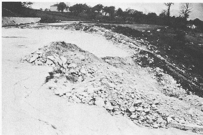
Bild 26. Risschäden in der Umfahrungsstrasse von Lioni
