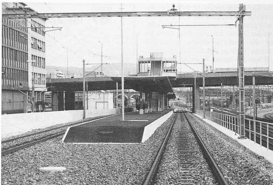
Bild 6. Blick auf die neue Haltestelle «Hardbrücke»
