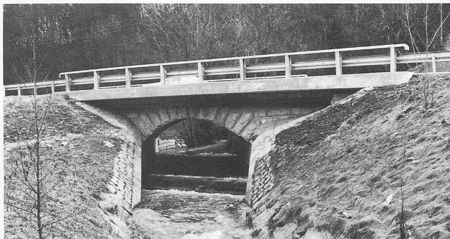
Bild 25. Die sanierte und verbreiterte Zeiherbachbrücke B-414 in Hornussen
