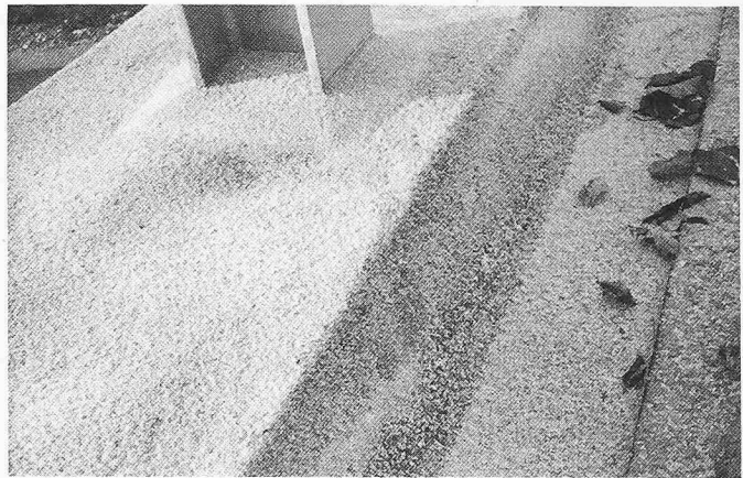
Bild 24. B-731. Fertig sanierter Konsolkopf mit Beschichtung
