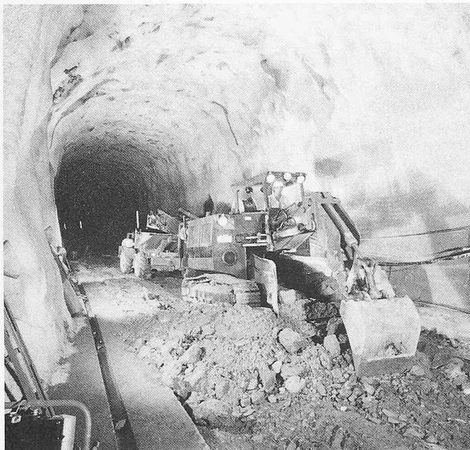
Bild 17. Sohlenreinigung bei Tm 6600
