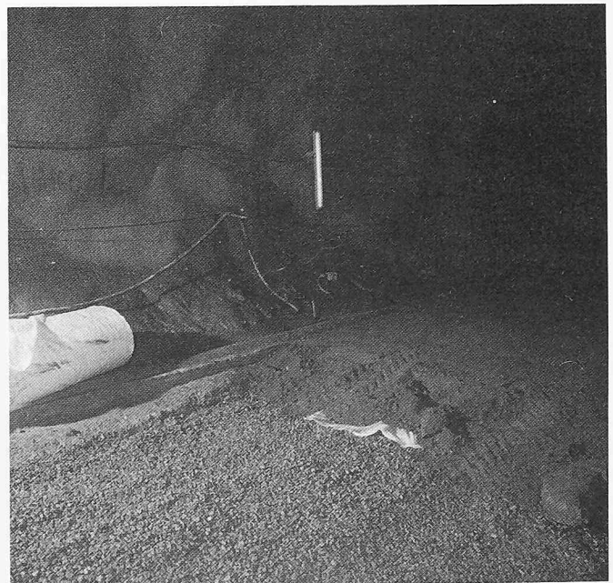
Bild 18. Bahnunterbau. Filterkies und Mitteldrainage. Eingewalztes, zementstabilisiertes Ausbruchsmaterial
