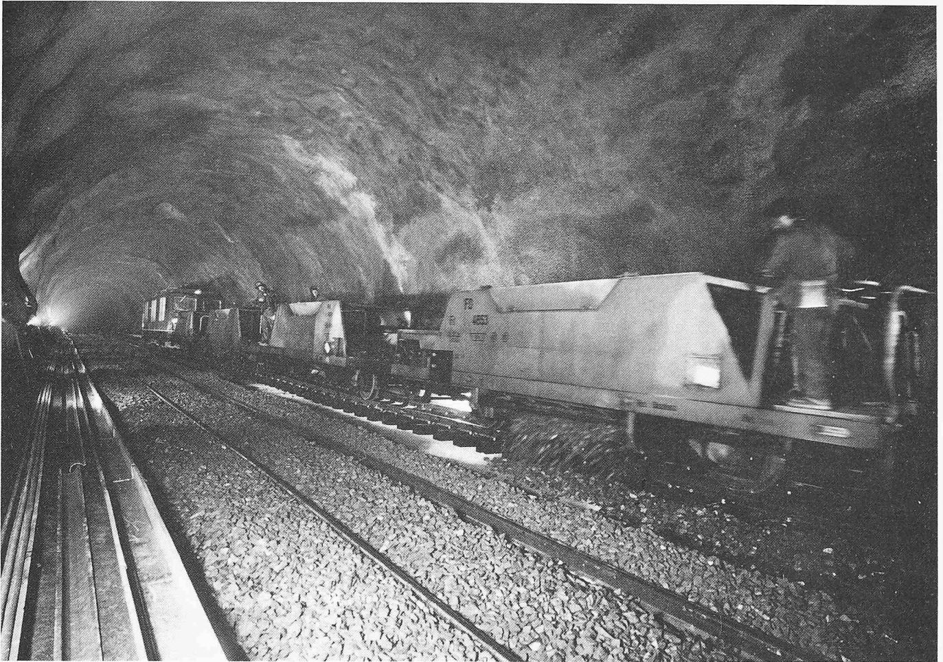
Bild 19. Schotterzug in der Kreuzungsstelle Tunnelstation Rotondo
