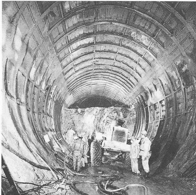
Bild 10. Strossenabbau im Kreisprofil
