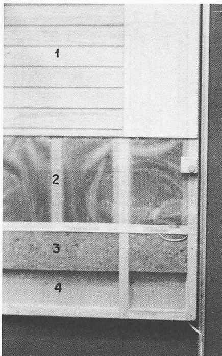
Elektrische Heizfolie. 1 Innenraum-Holztafer, 2 Heizfolie, 3 Wärmedämmung, 4 Mauerwerk
