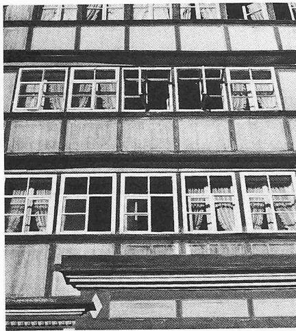
Bild 30. Additive Öffnungen an der Hauptfassade mit auskragenden Giebeln (Schwellbrunn AR)
