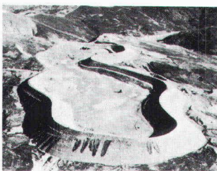
Bituminöse Aussenhautabdichtungen - eine unserer Spezialitäten
