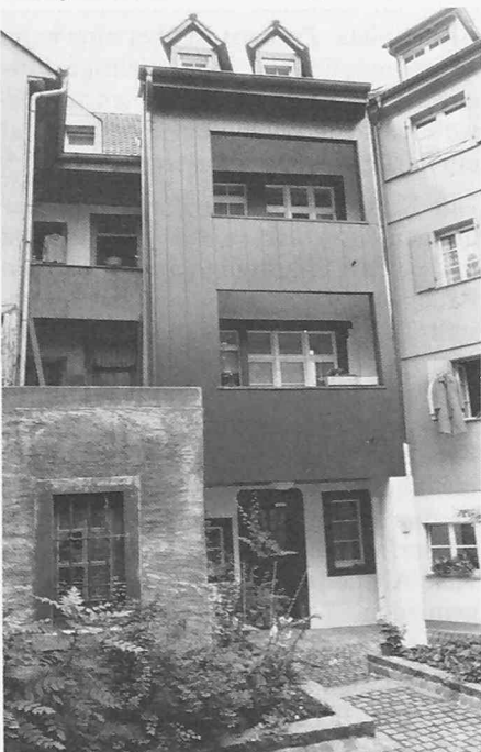
Rheingasse 69, nach der Sanierung
