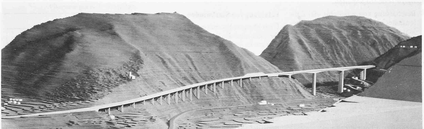
Bild 1. Gesamtansicht der Talbrücke Biaschina und des im Süden anschliessenden Hangviaduktes San Pellegrino
