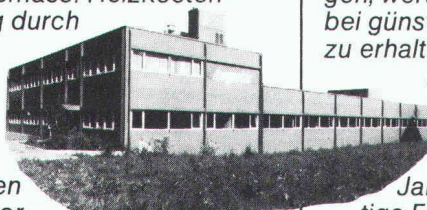
Industriebau in Liestal, BL. Neubau mit Kunststoff-Fenstern.
