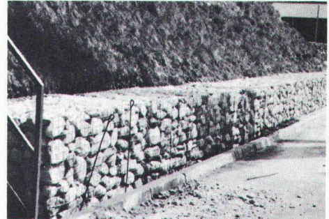
Beispiel einer Böschungserbauung
