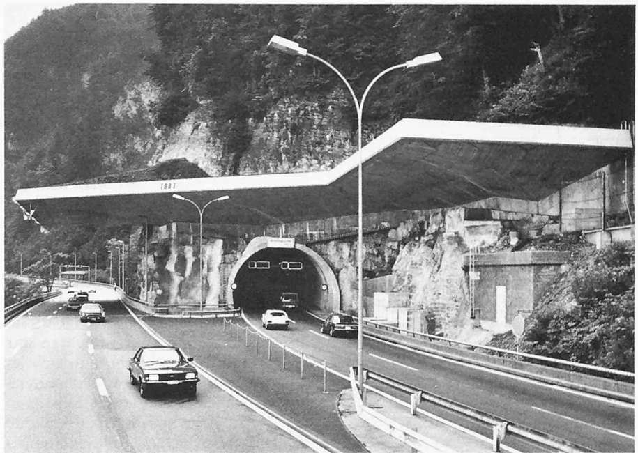
Bild 6. Steinschlagschutzbauten am Lopper (Los 1) über dem Westportal des bergseitigen Acheregg隧NELS
