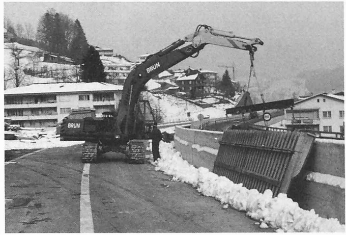
Bild 6. Januar 1981: Bau der New-Jersey-Mauer. Verkehrsführung: Gegenverkehr auf der Seeseite
