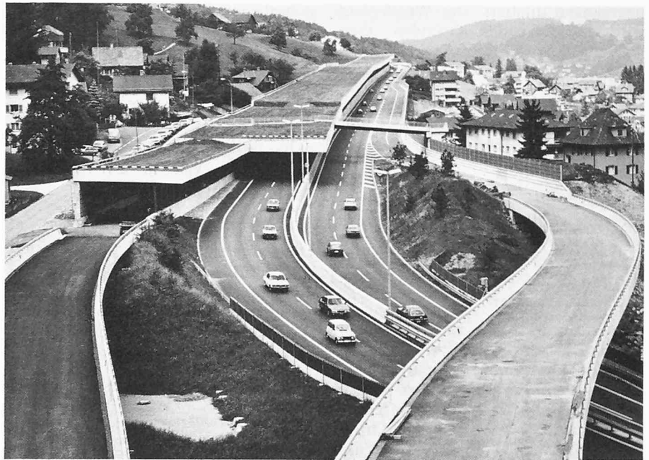
Bild 12. Anschluss N2/N8. Brücken (Baulos 42), Trasse (Baulos 15) und Lärmschutzgalerie (Baulos 62). Blick vom Loppertunnel in Richtung Norden
