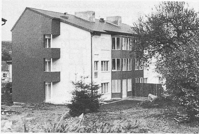
Bild 8. Südfassade mit Wintergarten
