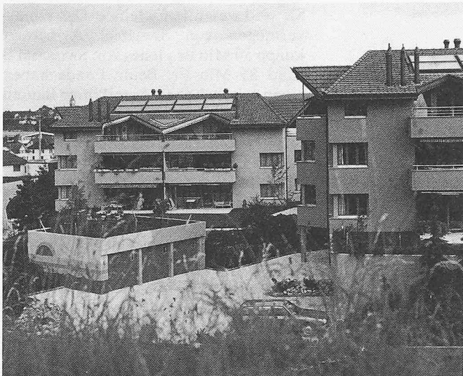
Bild 20. Die südwestorientierten Fassaden
