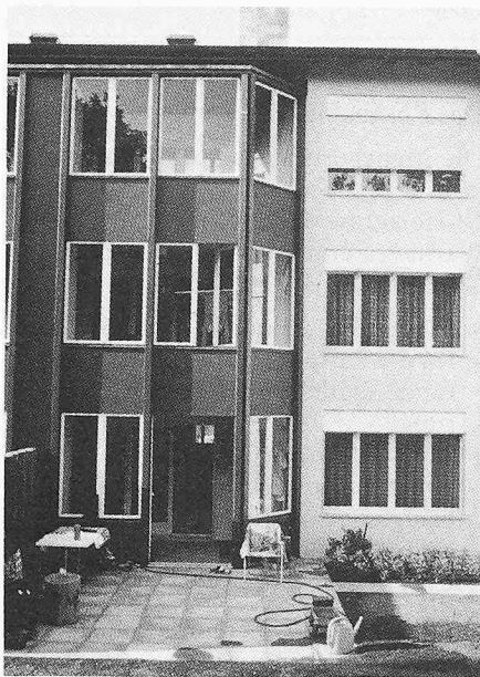
Bild 11. Wintergarten von aussen
