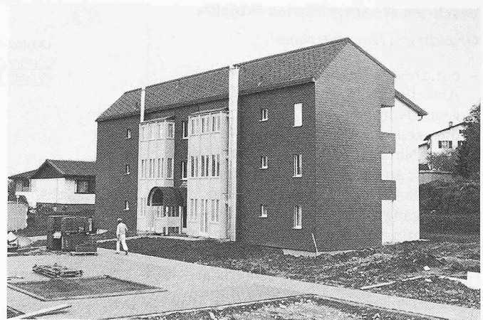
Bild 9. Nordfassade mit Vestibül und Nordkaminen
