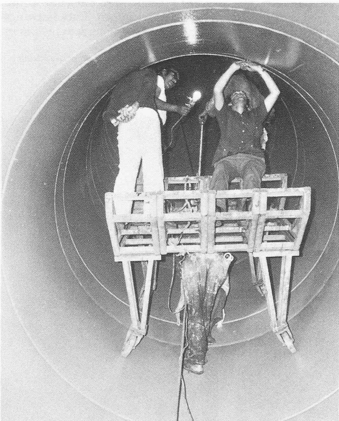
Bild 11. Dieser demontierbare Wagen war in diesem Projekt nicht vorgesehen worden und er hatte nachträglich konstruiert werden müssen, was lange nicht in allen Ländern möglich gewesen wäre. Es wird hier eine 220 Volt-Handlampe als Beleuchtung verwendet, was im Innern dieser Druckleitung unzulässig ist (vgl. Abschnitt «Beleuchtungsprobleme»)
