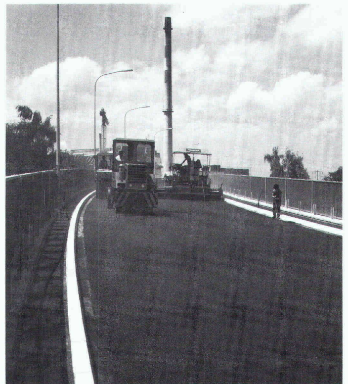
Einbau der Schutzausgleichs- und Verschleiss-Schichten
