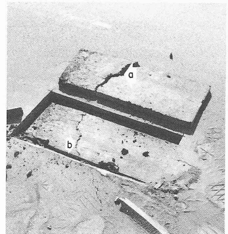
Bild A5. Die Verschleisschicht hat auf der Ausgleichsschicht geschoben (a) und ist gerissen. Unter dem Riss (b) steht ein «Schmutzkamm» auf der Ausgleichsschicht; sie liess sich nur brockenweise entfernen. Bei näherer Prüfung zeigten sich Ablösungen der Abdichtung in der Oberflächenzone des Betons
