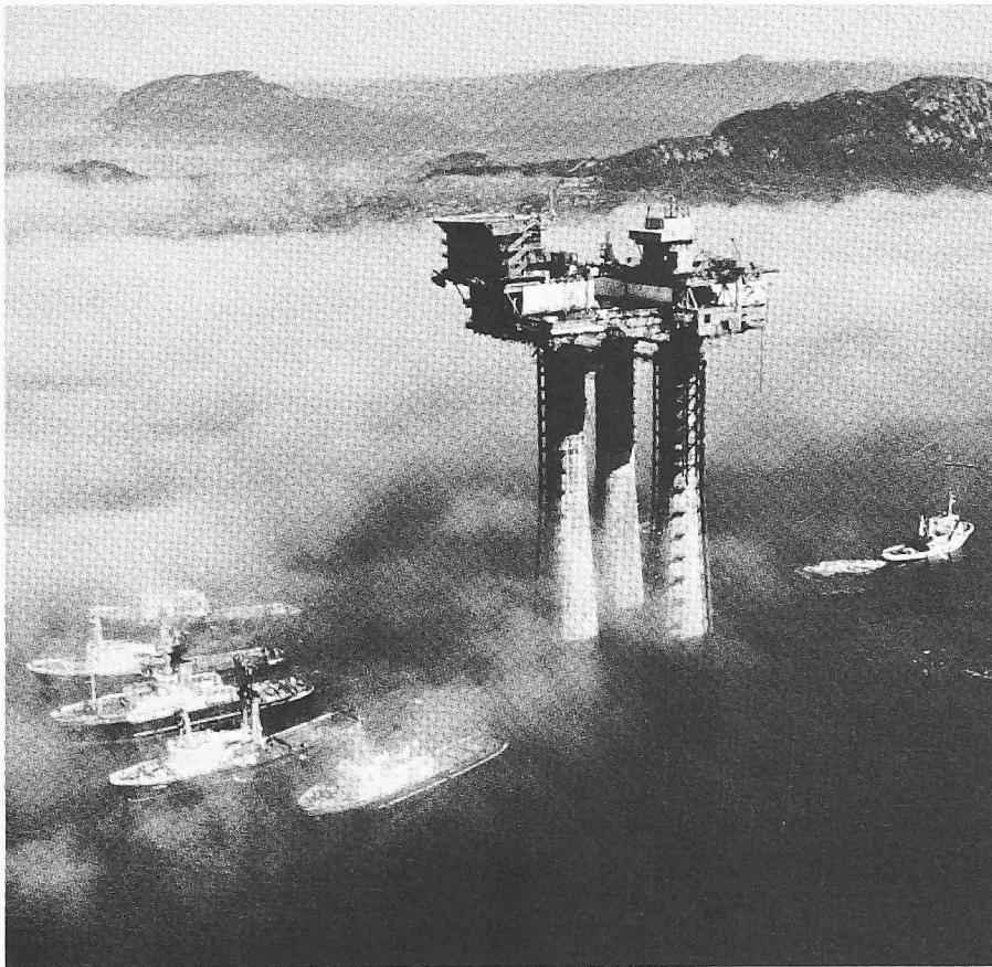
Bild 6. Die fertige Bohrplattform wird über 400 km Distanz zum Ölfeld geschleppt
