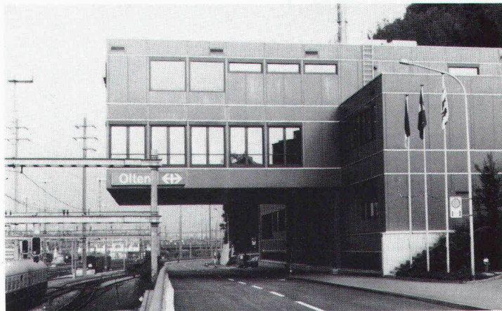
Neues Stellwerk Bahnhof SBB, Olten, Fahrbahnisolierung
