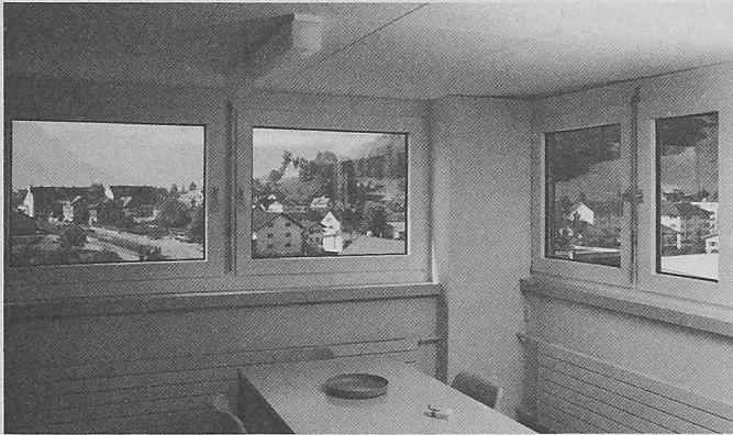
Sarnapane-Kunststoff-Fenster in einem modernen Industriegebäude
