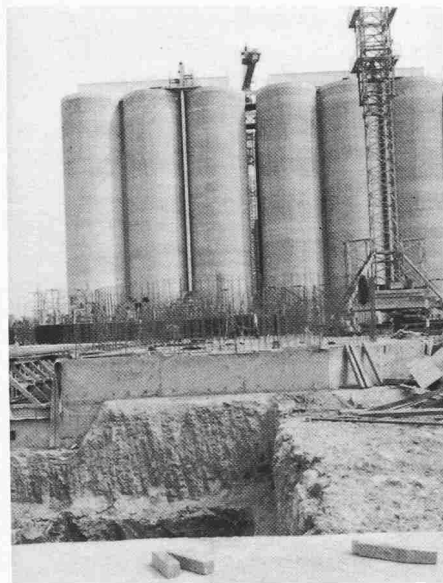
Bild 6. Mühle Quasseem, Saudi-Arabien. Getreidesilos der ersten Etappe und Maschinenhausbaugrube der zweiten Etappe (Photo Baustelle)
