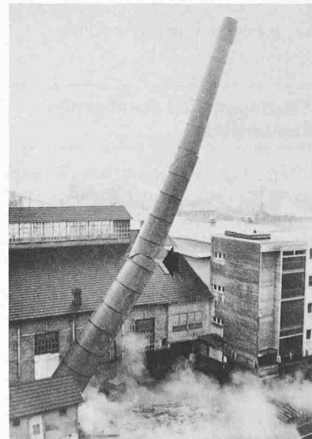
Bild 2. Beispiel für Knickstelle (Waggon-Fabrik Schlieren)
