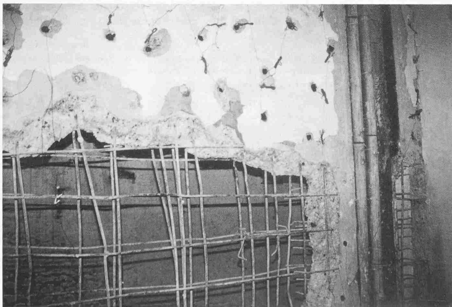
Bild 6. Seitenwand des Liftschachtes. Die untere Hälfte ist bereits gesprengt, der obere Teil ist geladen und für die Sprengung vorbereitet
