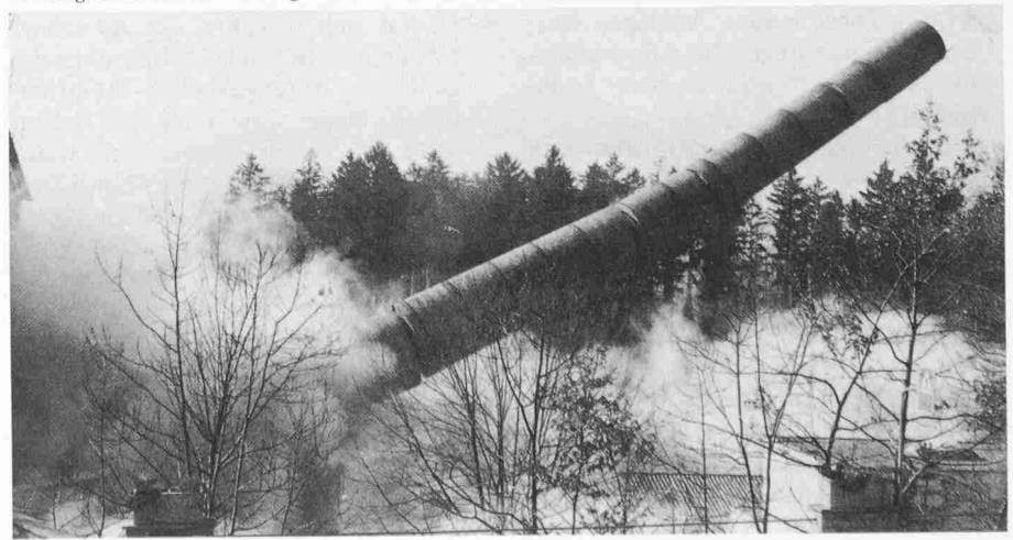
Bild 2. ... aber erst jetzt – in bald horizontaler Lage – treten Risse auf. Sie sind jedoch senkrecht zur Kaminlängsachse und nicht schräg dazu, wie das in der Regel der Fall ist (Badener Tagblatt)
