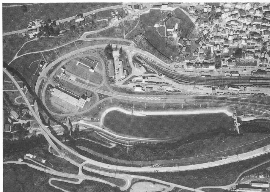
Bild 6. Neue Luftaufnahme einer Zone in Airolo mit abgeschlossenen Autobahnarbeiten; Kamerastandpunkt 800 m über dem Gelände, Fotokamera Wild RC 10, 23x23 cm
