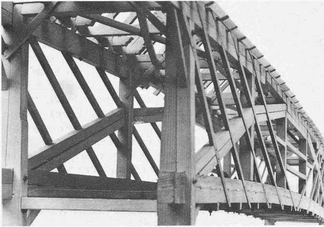
Im «Kubel» bei Herisau, gedeckte Holzbrücke über die Urnäsch, 1780 erbaut durch Hans Ulrich Grubenmann. Fünfseitig doppelläufiges Stabpolygon mit verzahntem Streckbalken. Modell von J. Heer
