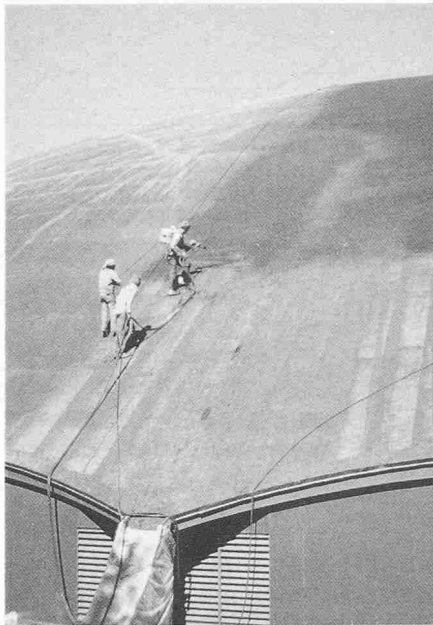
Bild 6. Abdichten der Dachhaut
