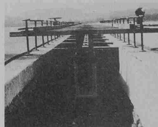
Rinne versetzt, vor dem Betonieren
