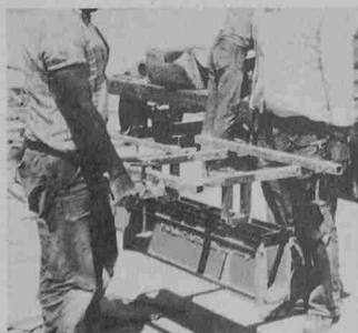
2 Mann tragen Polydrain mit Versetz-einrichtung
